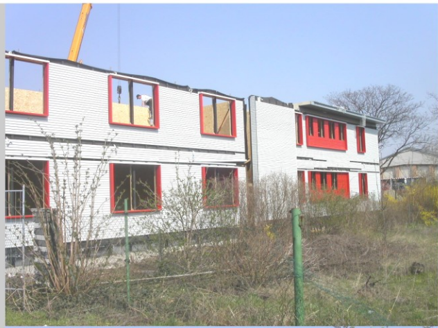
U2-6 Montage der Fertigteile großformatige Wandelemente Deckenelemente Dachelemente sind vorgefertigt. Innerhalb einiger Tage ist der Rohbau errichtet. (ebenso U2-6, U2-8, U2-10)
